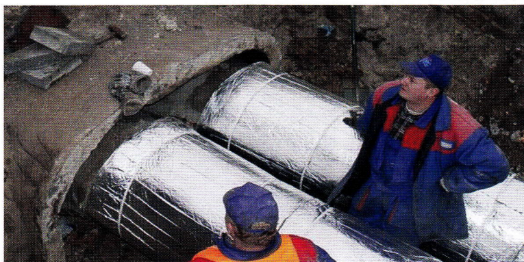
FOT. 6 KANAŁ NIEPRZECHODNI W SYSTEMIE CIEPŁOWNICZYM
