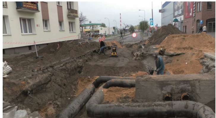
FOT. 2 Budowa sieci ciepłowniczej w technologii preizolowanej
