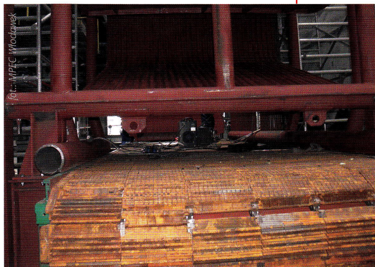
FOT. 1 Montaż części ciśnieniowej modernizowanego kotła
