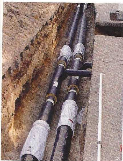
Zdjęcie 1. Budowa sieci ciepłej w ulicy Brzeskiej we Włocławku
