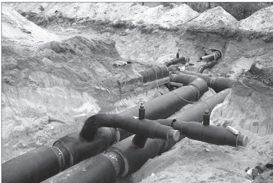
Fot. 1. Budowa typowej magistrali ciepłowniczej w systemie rur preizolowanych we Włocławku w rejonie ulic Ostrowska–Okrężna
