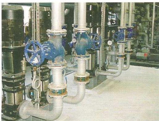
Na zdjęciu po lewej stronie są pompy mieszania gorącego technologii CR64-2. W środku pompy obiegu technologii Zakładu Ceramiki CR32-5. Pompy te są nie eksploatowane i dlatego nie ma ich na schemacie. Dalej na zdjęciu są pompy obiegu letniego typu NKG80-160
